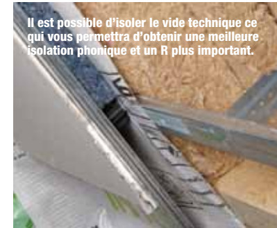
d) Suspen + fourrure + membrane + Sixbox® ou tasseau de bois (vide technique 15 mm à 100 mm) + fourrure
