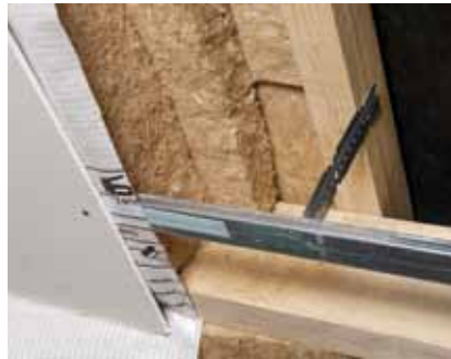
b) Suspen + fourrure + membrane (pas de vide technique) + parement
